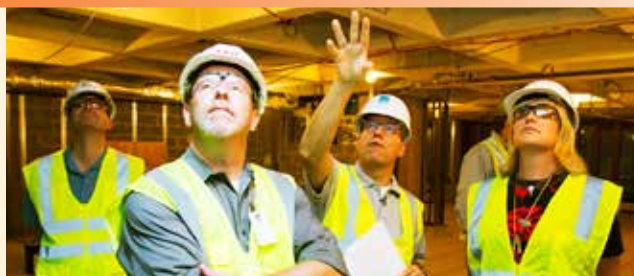
副总裁卡拉·格拉索（右）在视察总部一号楼翻新工作的进展情况。
